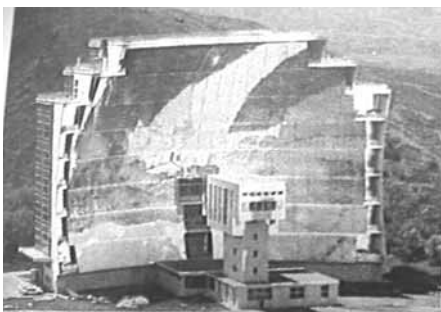
איור 9-8: מראה סולרית מרכזת אור המשמשת לצרכים מדעיים. מוקד המראה נמצא בתוך המעבדה, שם משתמשים באנרגיית האור המרוכזת. הטמפרטורה שניתן להגיע אליה במתקן זה היא כ- 3,800^{\circ} צלסיוס.
